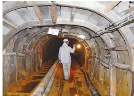
花輪鉱山 坑道点検の様子
