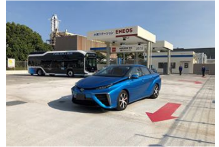
東京大井水素ステーション
