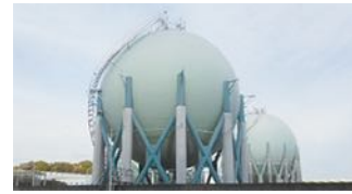
球形タンクのブレース（筋交い）補強
