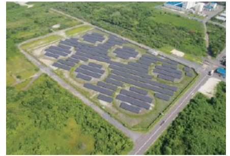
下松メガソーラー発電所
