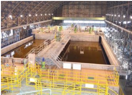
豊羽鉱山 本山坑廃水処理場の様子
