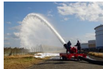
大容量泡放水砲（大分製油所）
