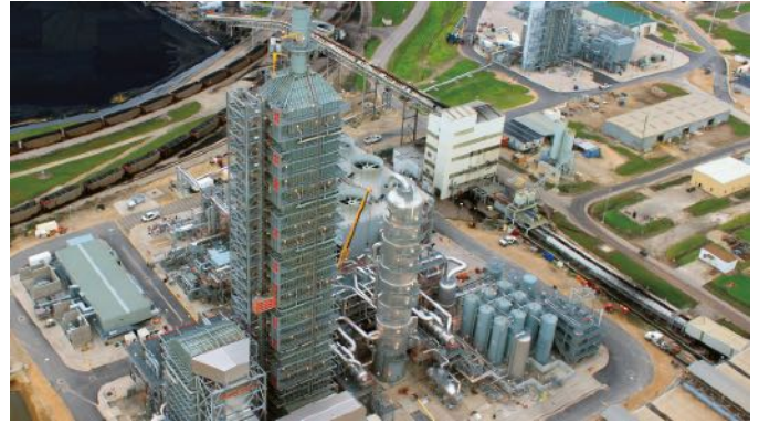
CO 2 回収プラント（米国テキサス州）
